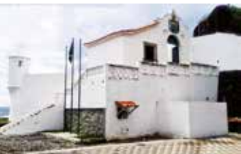
Edifício do comando do forte de São Diogo da Bahia, 1722 (c.) e seguintes, São Salvador da Bahia.
