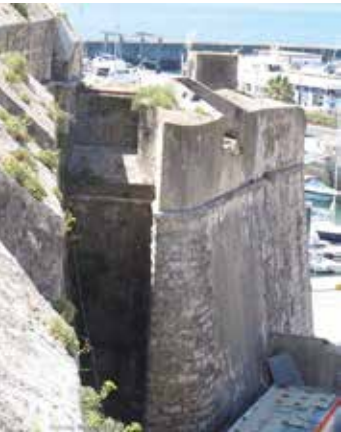
Figura 17. Flanco e orelhão recto do baluarte do forte de Cascais. / Straight flank and orillion of the bulwark of the fort of Cascais.
