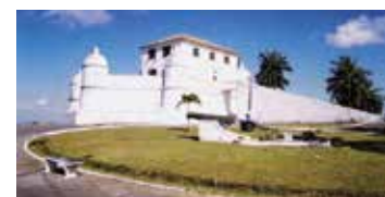
Forte de Nossa Senhora de Monserrate ou Monte Serrat, reconstrução de 1700 a 1724, Bahia, Brasil.
