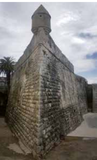
Figura 6. Baluarte frontal da fortificação. Podemos apreciar a sua forma tão aguda e estreita, e como as casamatas dos flancos dos baluartes opostos ficam descobertas perante o ataque da artilharia inimiga. / Frontal bulwark of the fortification. We can appreciate its very sharp and narrow shape, and how the casemates on the flanks of the opposing bastions are uncovered in the face of an attack by enemy artillery.
